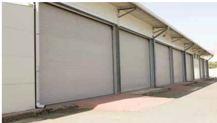
Manovra elettrica con motore laterale Secondo UNI-EN 13241-1 /2004
