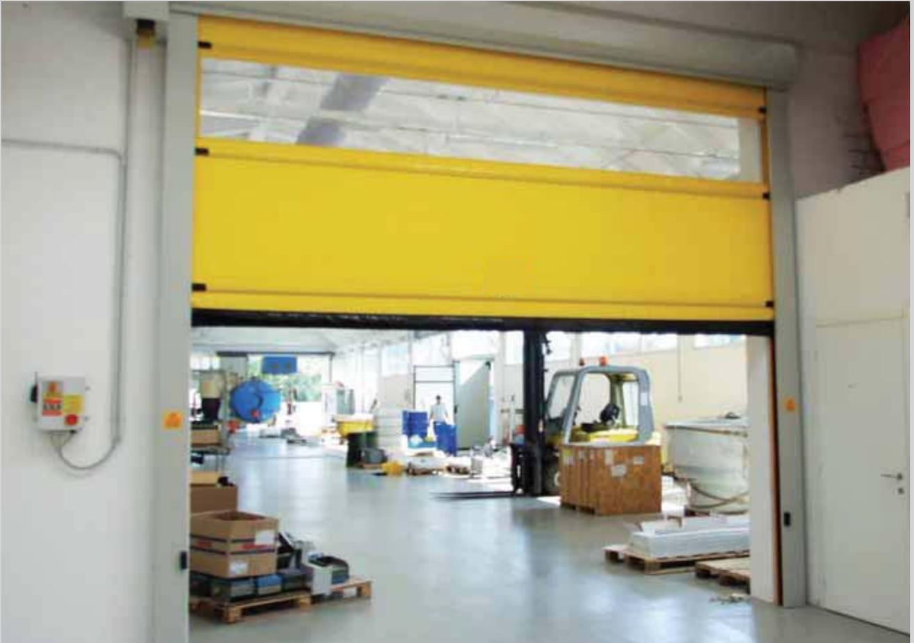
Porta rapida serie RA completa di una sezione visiva, colore standard giallo RAL 1021.
