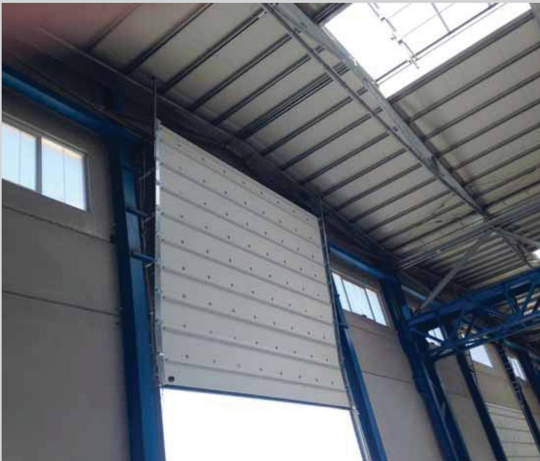
Portone sezionale serie SI di grandi dimensioni con omega di rinforzo studiati e progettati da Aiello Sicurser, vista interna. *SI series sectional door of big dimensions, reinforced with omega-shaped bars designed by Aiello Sicurser, internal view.*
